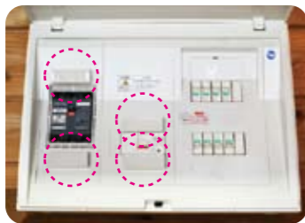
フタ付きブレーカーの場合は、フタを開いて、写真のように取り付けやすい位置にスタビライザーを貼り付けてください。
