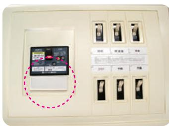
カバーの上から貼る場合は、できるだけ主幹ブレーカーおよび漏電ブレーカーの近くに貼り付けてください。
